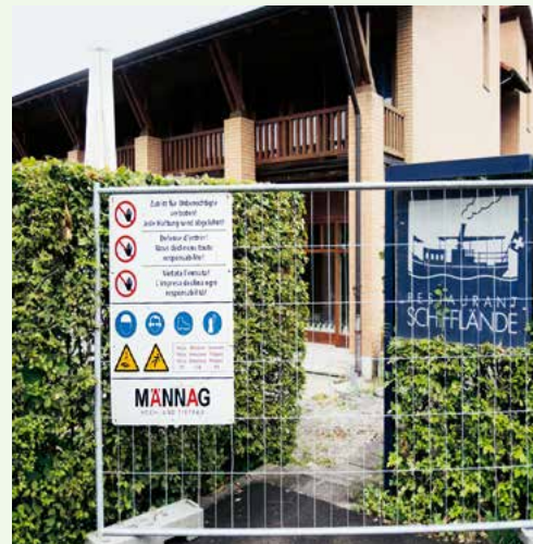
Betreten der Baustelle verboten: Die «Schifflande» wird noch länger keine Gäste empfangen.
